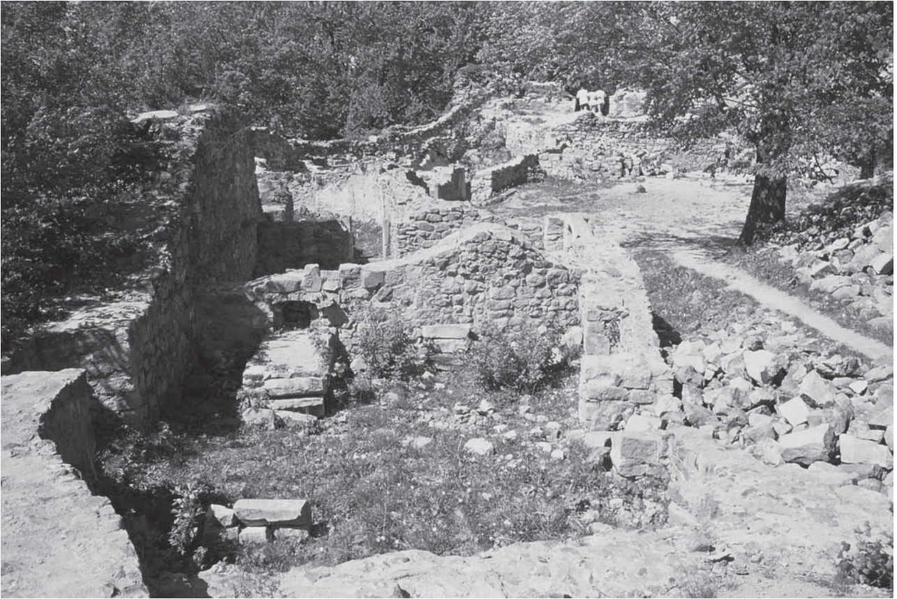
Ryc. 118. Łupki – Wleński Gródek. Zamek Wleń. Wschodnia część zabudowy zamku górnego (stan z 1998 r.) (fot. M. Wiktorski).
