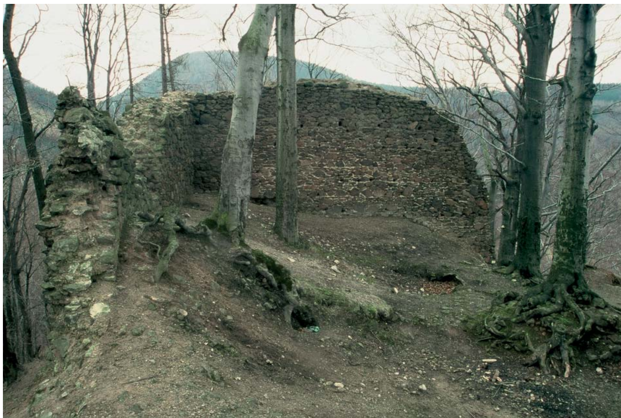
Ryc. 231. Wałbrzych – Podgórze. Zamek Nowy Dwór. Relikty budynku mieszkalnego na zamku górnym (fot. M. Wiktorski).
