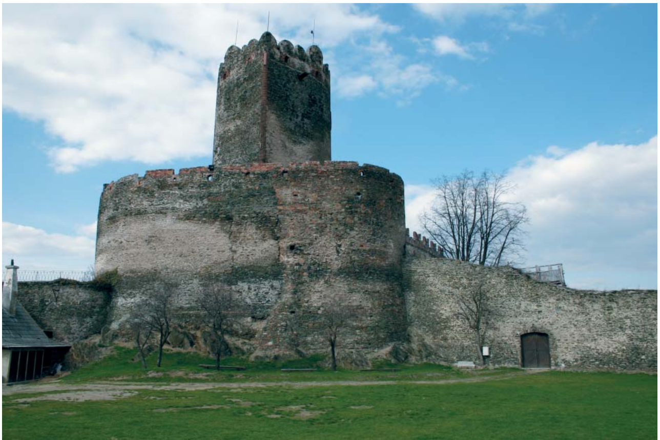
Ryc. 133. Bolków. Zamek górny i wieża z ostrzem od strony dziedzińca południowego (fot. A. Boguszewicz).
