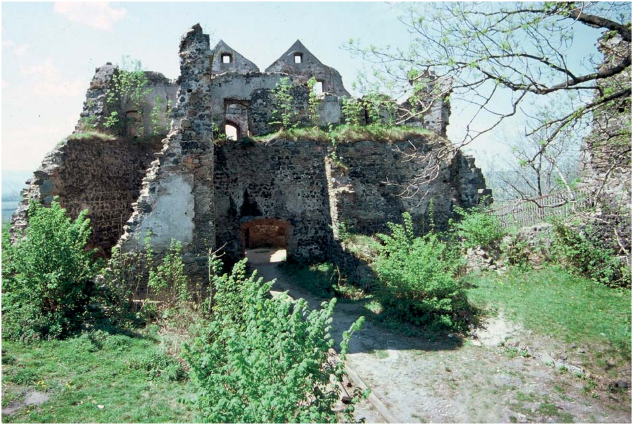
Ryc. 211. Proszówka. Zamek Gryf. Widok dziedzińca zamku górnego od strony wschodniej (fot. M. Wiktorski).
