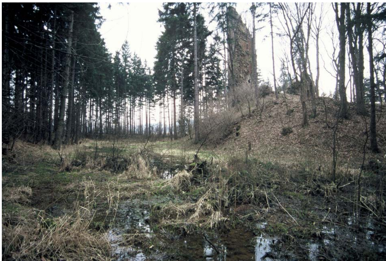
Ryc. 95. Czarny Bór. Widok zamku od północnego zachodu (fot. M. Wiktorski).
