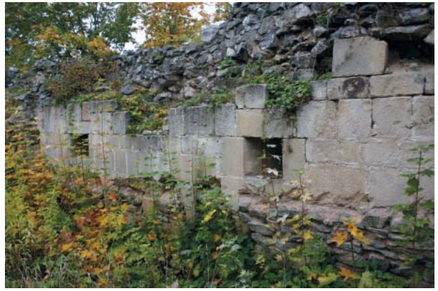
Ryc. 105. Łupki – Wleński Gródek. Zamek Wleń. Wschodnia ściana budynku z ciosów (fot. A. Boguszewicz).
