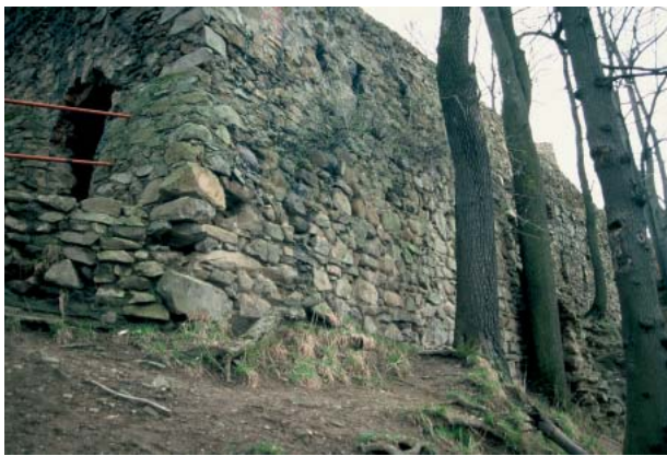
Ryc. 236. Wałbrzych – Stary Książ. Południowo-zachodni narożnik głównego członu warowni z zachowanym w przyziemiu fragmentem średniowiecznego muru obwodowego (fot. M. Wiktorski).
