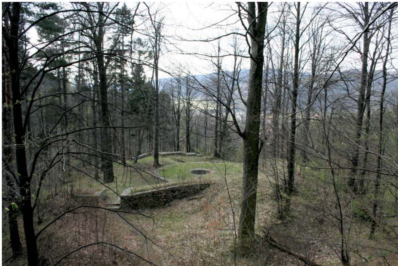
Ryc. 72. Bardonia. Główny człon zamku. Relikty bramy i cylindrycznej wieży po konserwacji (fot. A. Boguszewicz).
