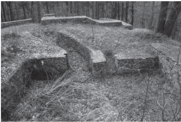
Ryc. 130. Bardzo. Główny człon zamku na Górze Bardzkiej. Re-likty podpiwniczonego budynku (C) z pochylnią (fot. A. Bogu-szewicz).
