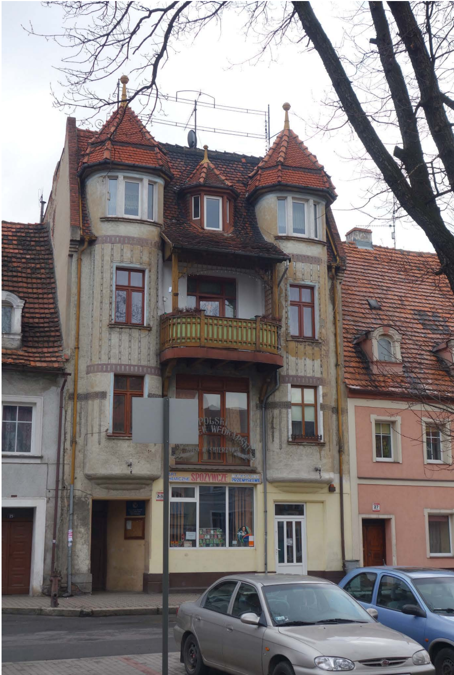
Il. 70. Kamienica rodziny Räder z początków XX w. na tzw. dolnym rynku w Świerżawie, stan współczesny. Właściciele tej kamienicy posiadali dobrze prosperujący zakład stolarski. Na dachu wzniesionego w początkach XX w. okazałego jak na Świerżawę budynku umieścili reklamę ze swym nazwiskiem i datą: Paul Räder 1910. Do dziś pozostał po niej fragment metalowej konstrukcji.
