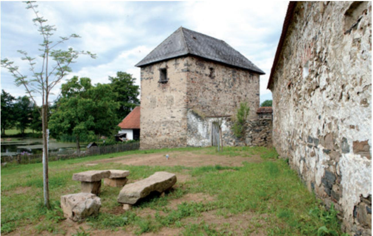
Abb. 11: Sudkův Důl, die Feste. Das Wohngebäude ohne Details aus dem gehauenen Stein. Im ersten Stock zwei für Blockstube typische (später zugemauerte) Fenster; im 2. Stock ein Fenster mit der Laibung aus Eichenholz (ursprünglich mit einem Kreuz geteilt) (Foto: Verfasser).
