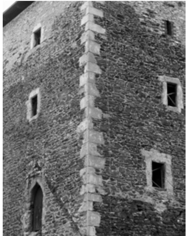
Abb. 10: Lošany, die Feste. Dekorative Wirkung und Kontrast: das Mauerwerk aus dunklem Bruchstein, Eckquaderarmatur, Portal und Fensterlaibungen aus hellem Sandstein (Foto: Verfasser).
