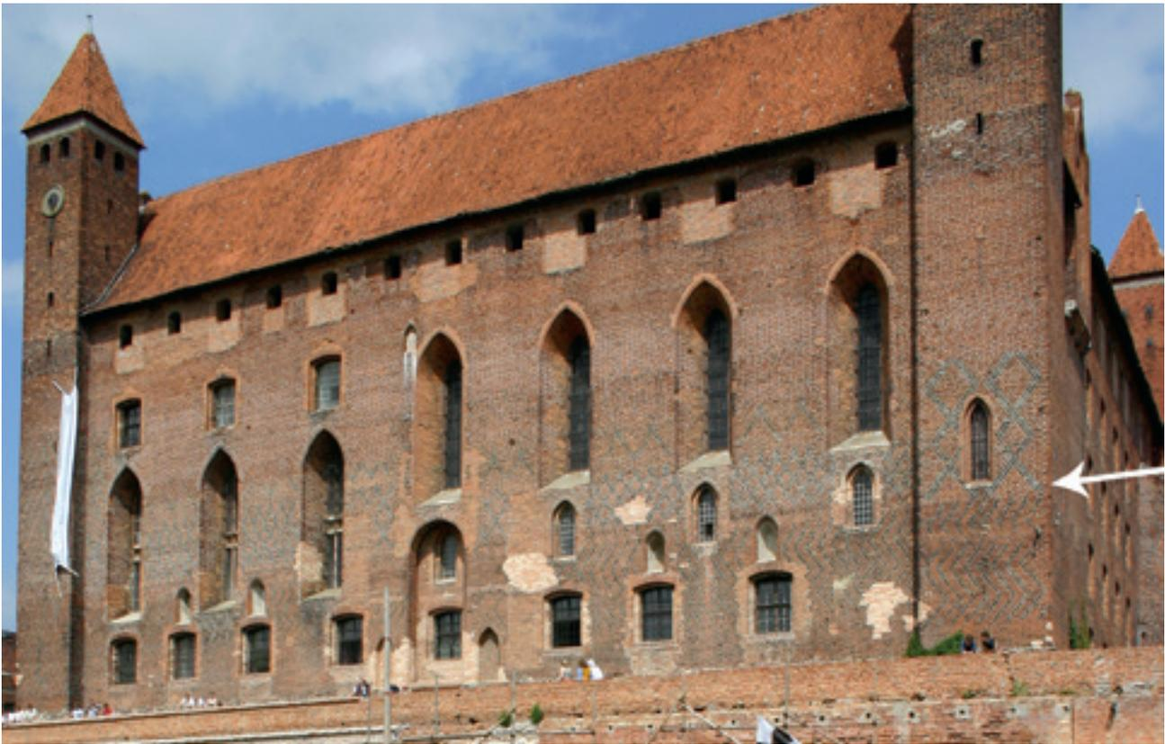
Abb. 4: Konventsburg Mewe/ Gniew, Ansicht von der Südseite: der Pfeil bezeichnet die Lage der horizontalen Baunaht (Foto/ Bearbeitung: Verfasser).
